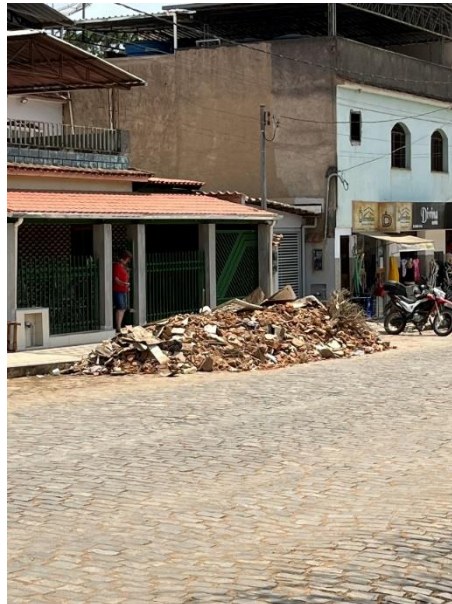
Figura 68: RCC disposto em frente à residência para coleta da Prefeitura.
