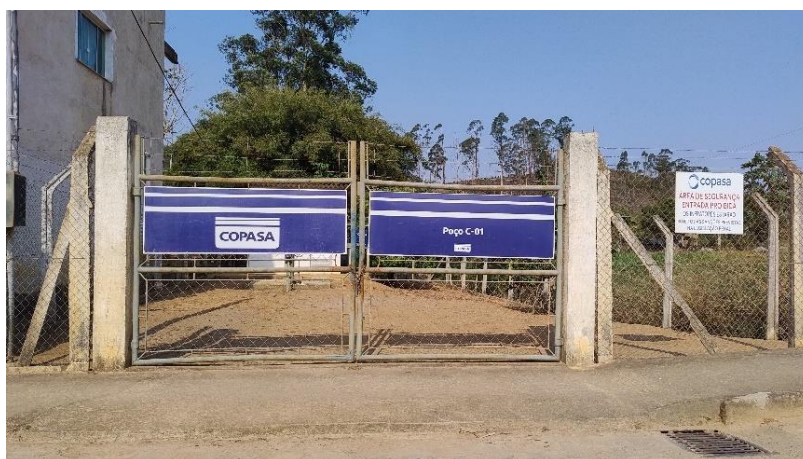
Figura 64: Poço da COPASA localizado em Santa Filomena.
