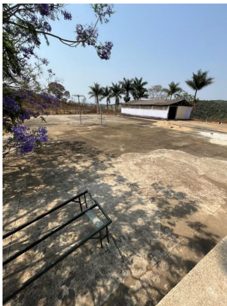
Figura 60: Pátio para a realização de compostagem.
