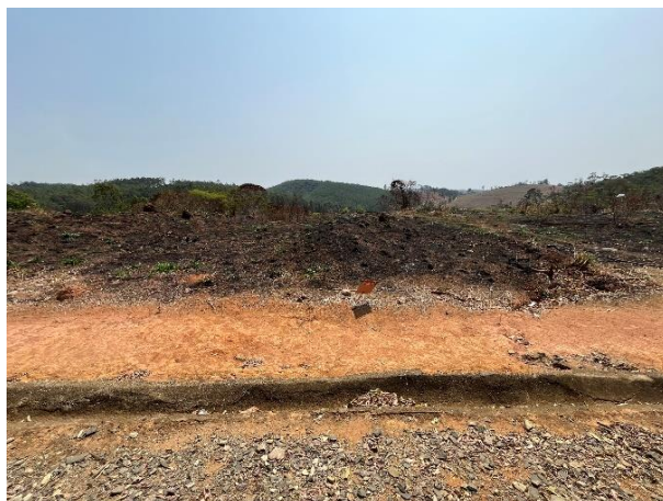
Figura 83: Área do aterro controlado, já recuperada.
