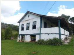
Categoria: Bens Imóveis/ Estrutura Arquitetônica Denominação: Fazenda Palmeiras Localidade: Povoado de Santa Filomena Área: Área Rural Ano de inventário: 2008/ Atualização: 2023
